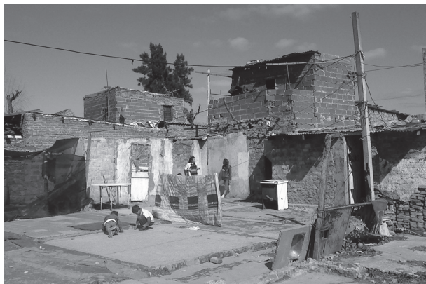
Mejoramiento en proceso en el barrio Santa Rosa, San Fernando, Septiembre de 2010. Fotografía del autor.
