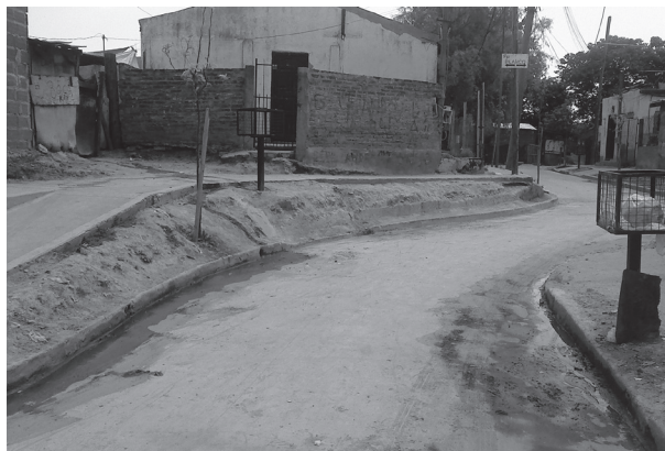
Mejoramiento Habitacional PROMEBA, Barrio Peron, San Fernando, 2011. Foto del autor.
